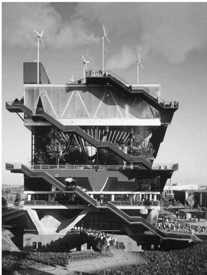
Padiglione dell'Olanda all'Esposizione Universale di Hannover del 2000 (MVRDV). Un gigantesco club sandwich di otto piani che propone differenti paesaggi della campagna olandese. Una stratificazione che estremizza il rapporto fra verde pubblico in un contesto urbano a elevata densità.
