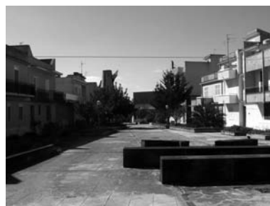
Fig. 4. Lo spazio interno pedonale di una delle insule
