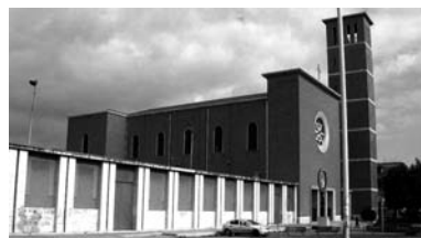
Fig. 1. S. Pio X, stato attuale con la corte murata sul sagrato
